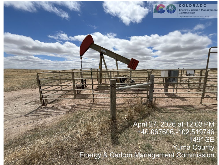
Wellhead and PU
