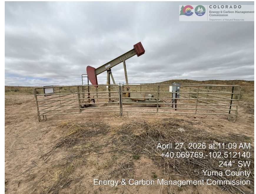
Wellhead and PU
