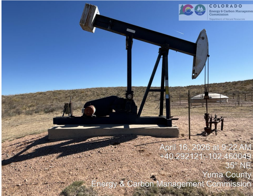
PU and Wellhead
