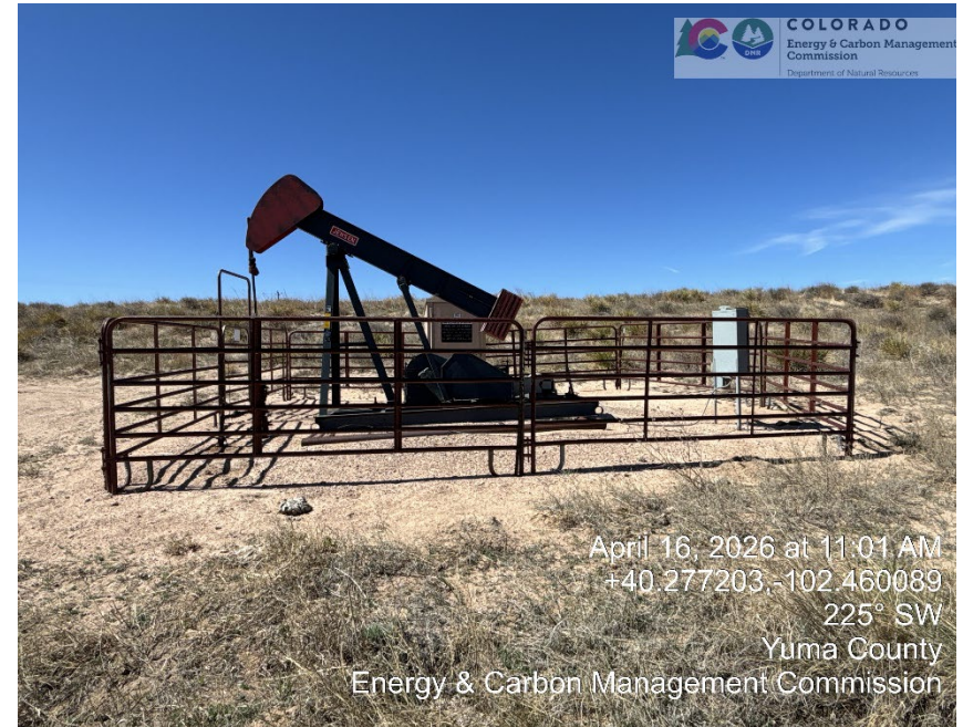
Wellhead and PU
