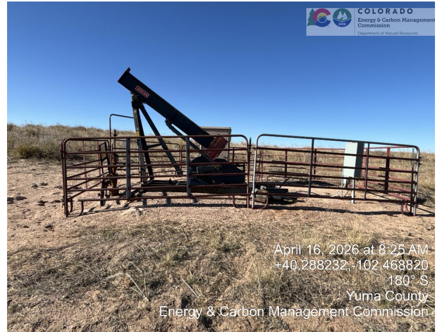
Wellhead and PU
