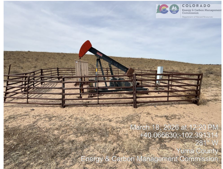
Wellhead and PU
