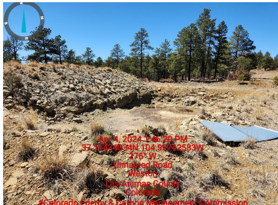
Photo2 loc pic unused door
