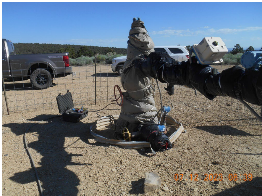
Injection wellhead during MIT
