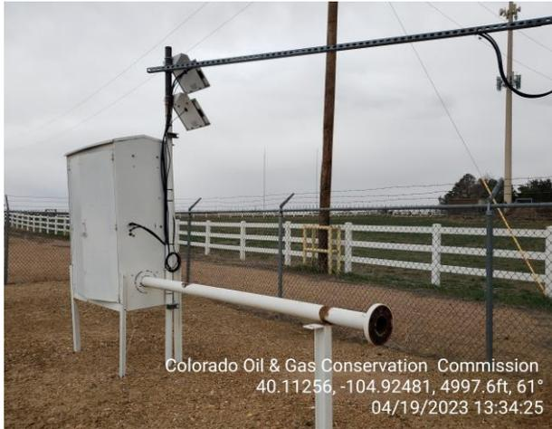
**Photo 7 Unused Gas Meter Run.**
