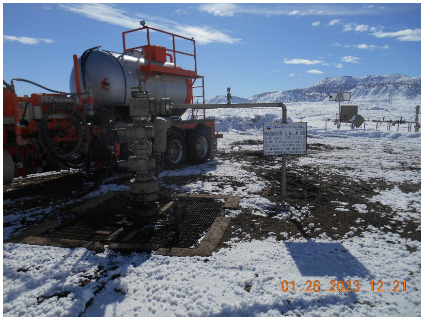
Injection wellhead during MIT
