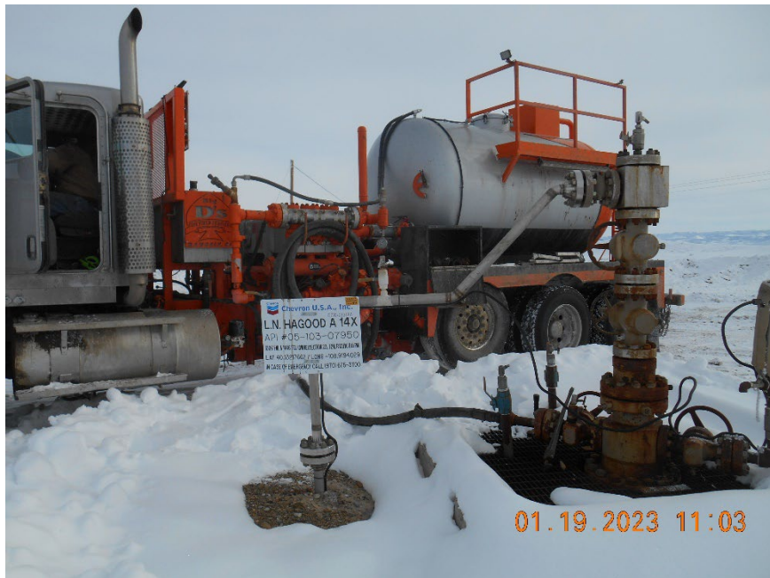
Injection wellhead during MIT
