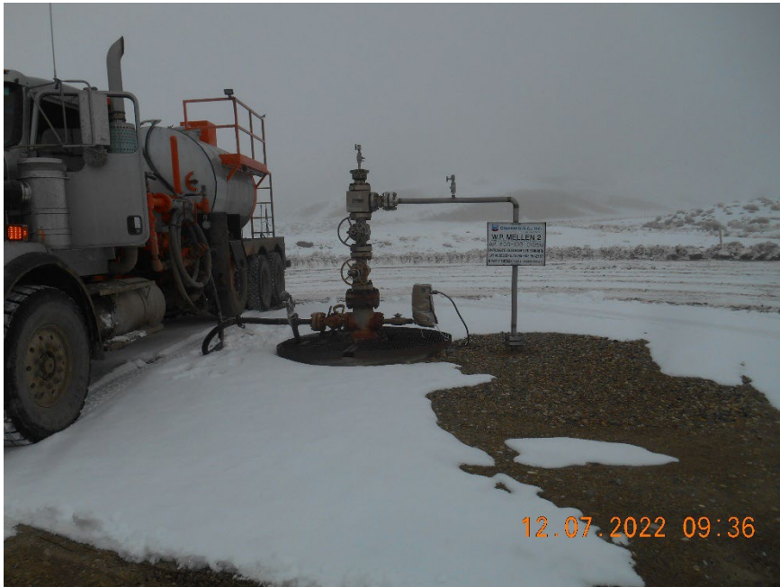
Injection wellhead during MIT
