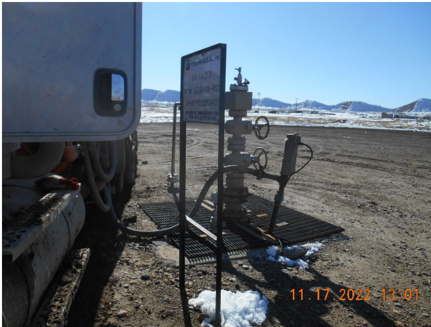
Injection wellhead during MIT
