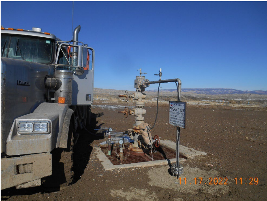
Injection wellhead during MIT
