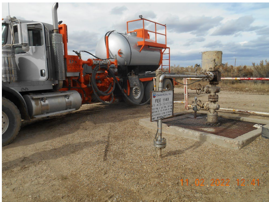
Injection wellhead during MIT
