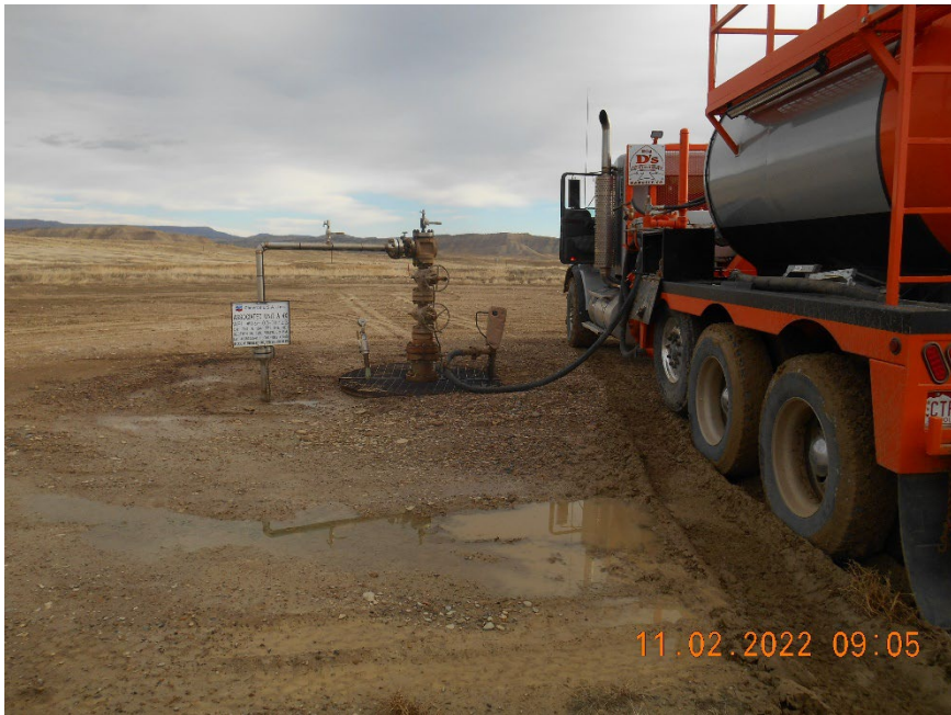
Injection wellhead during MIT
