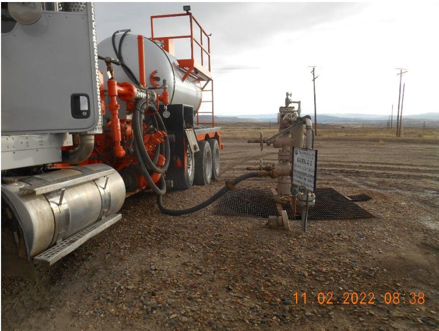
Injection wellhead during MIT
