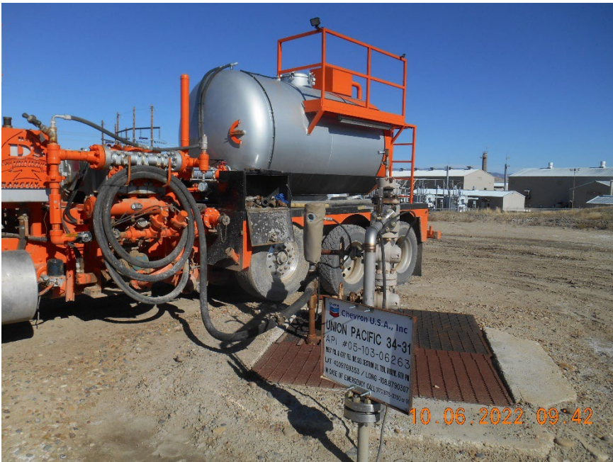
Injection wellhead during MIT
