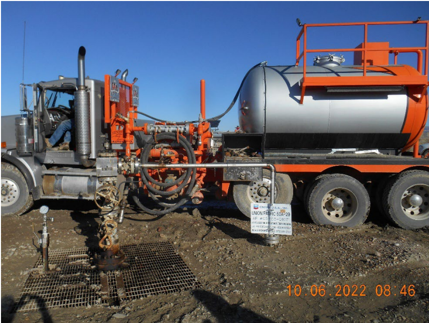
Injection wellhead during MIT
