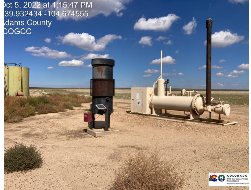
Pic 2 ECD, separator
