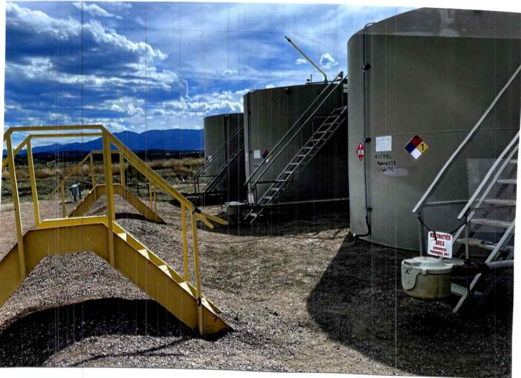
REMOVE VEGETATION FROM INSIDE TANK BATTERY CONTAINMENT PER RULE 606. CA DATE 10-3-2022
