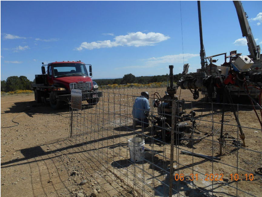
Injection wellhead during MIT
