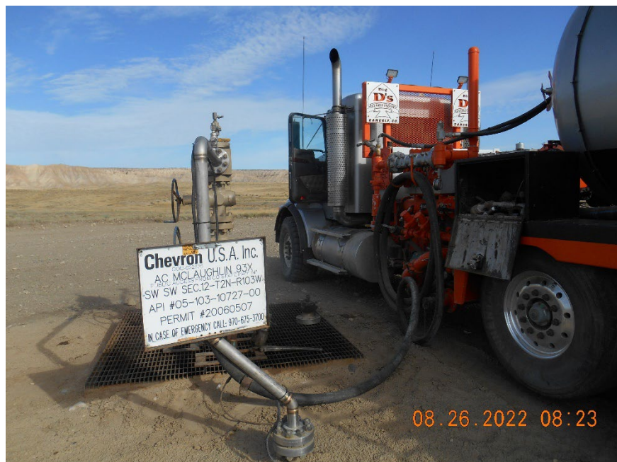
Injection wellhead during MIT
