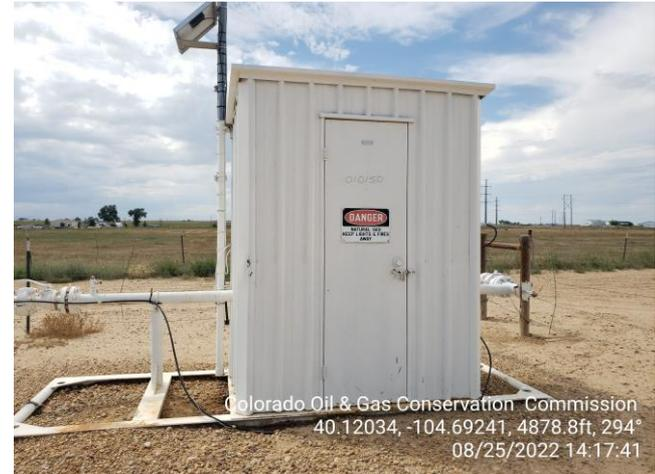
**Photo 7 Unused Gas Meter Run.**
