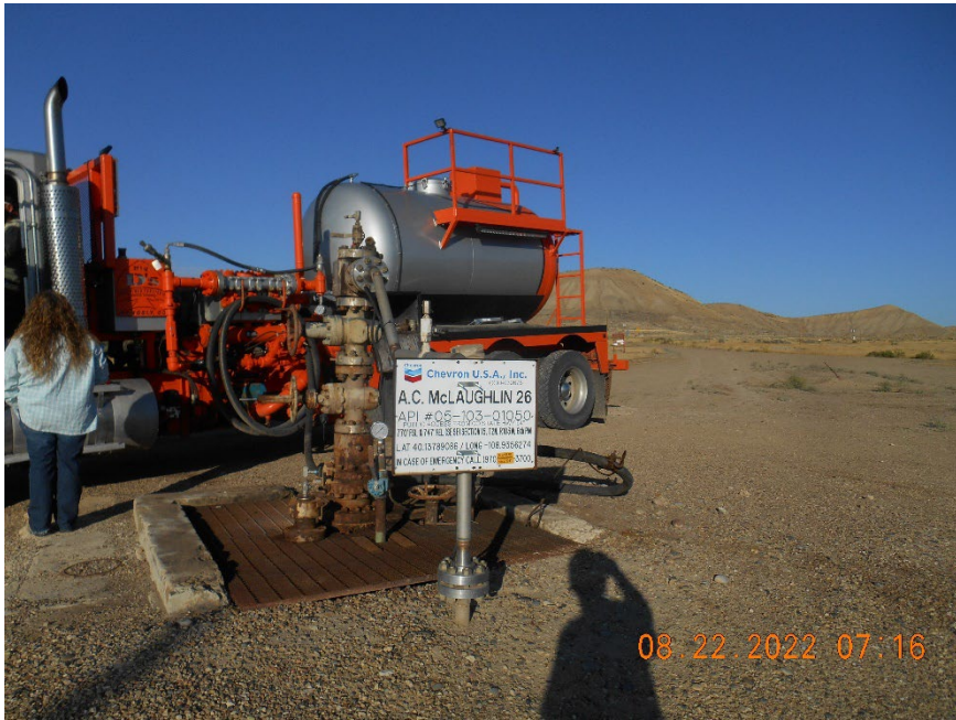
Injection wellhead during MIT
