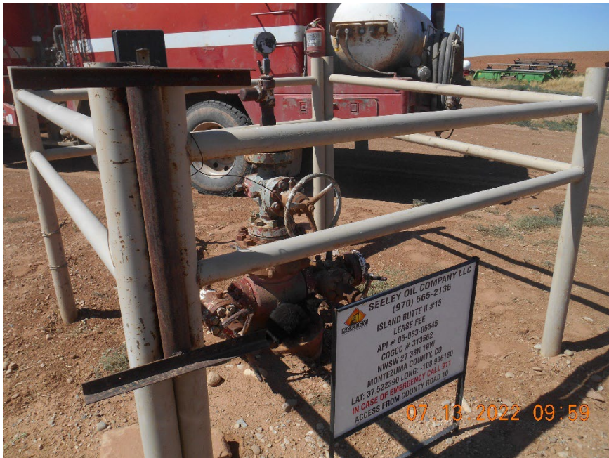
Wellhead during MIT
