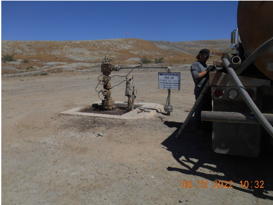
Injection wellhead during MIT
