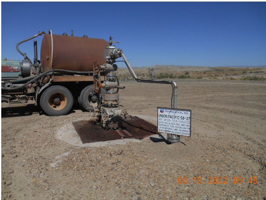
Injection wellhead during MIT
