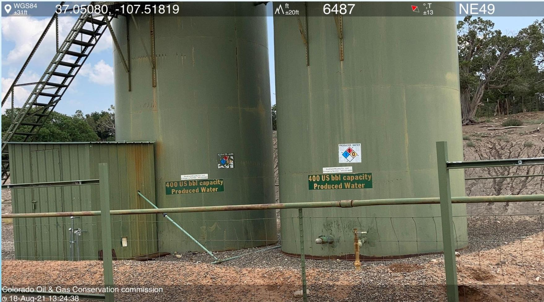
**PHOTO 3: TANK BATTERY/ NFPA STICKER ON LEFT PRODUCED WATER TANK IS LEGABLE AT TIME OF INSPECTION HOWEVER THE STICKER IS CRACKING AND PEELING AND SHOULD BE REPLACED SOON.**
