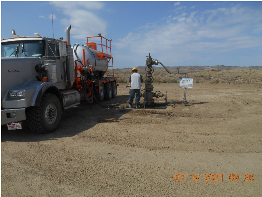
Injection wellhead during MIT
