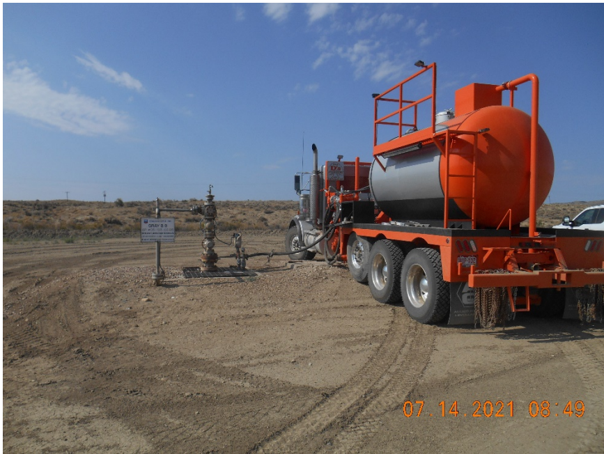
Injection wellhead during MIT
