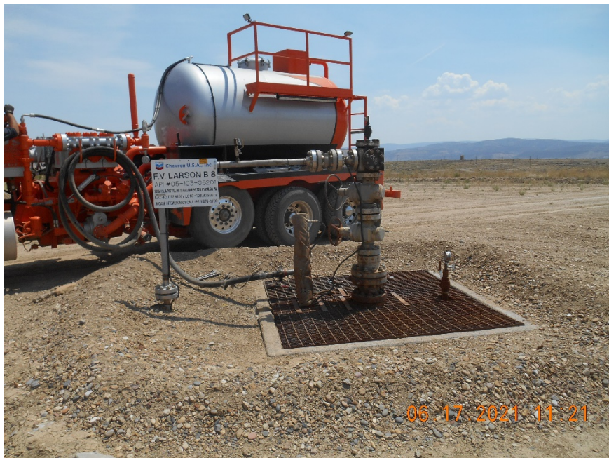
Injection wellhead during MIT
