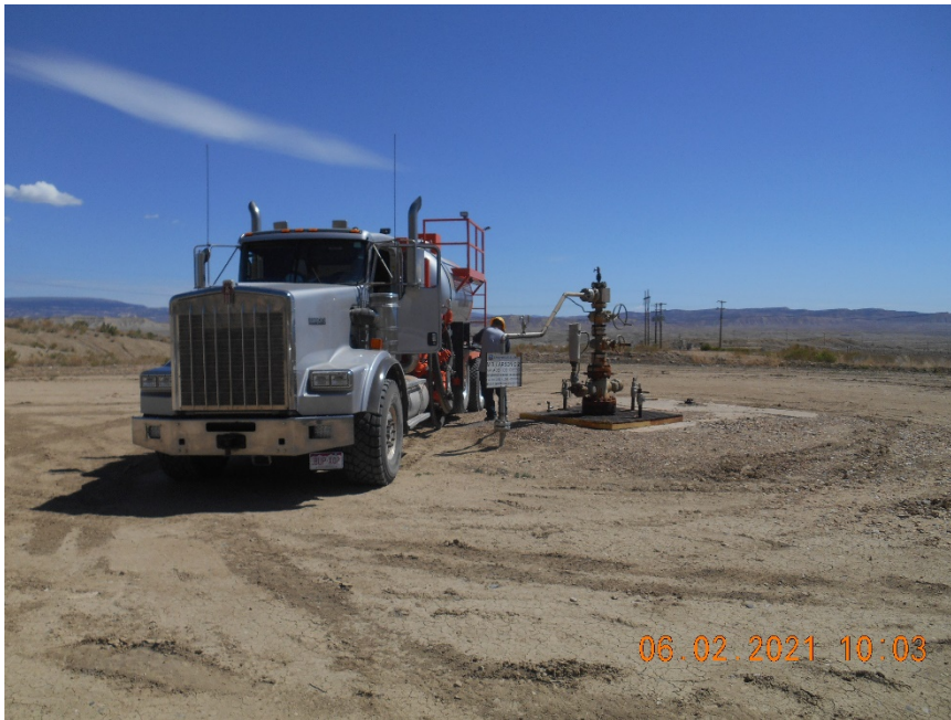
Injection wellhead during MIT
