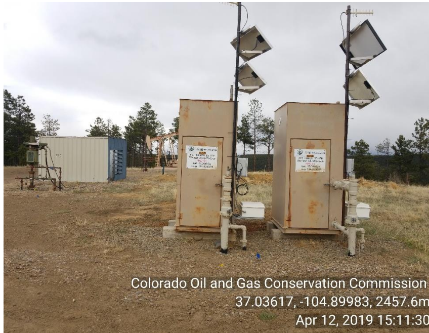
Photo 1 HR#33-13R and HR#33-13V duel sep/meter house
