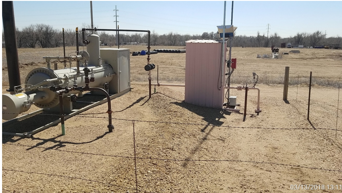
Separator & Meter Run
