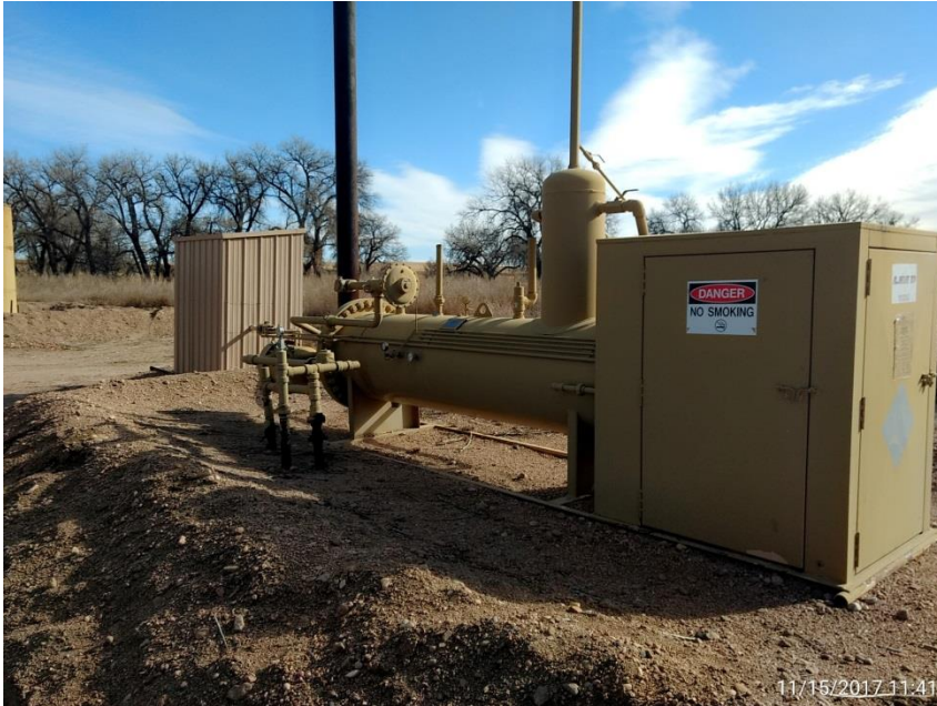
Separator & Meter Run
