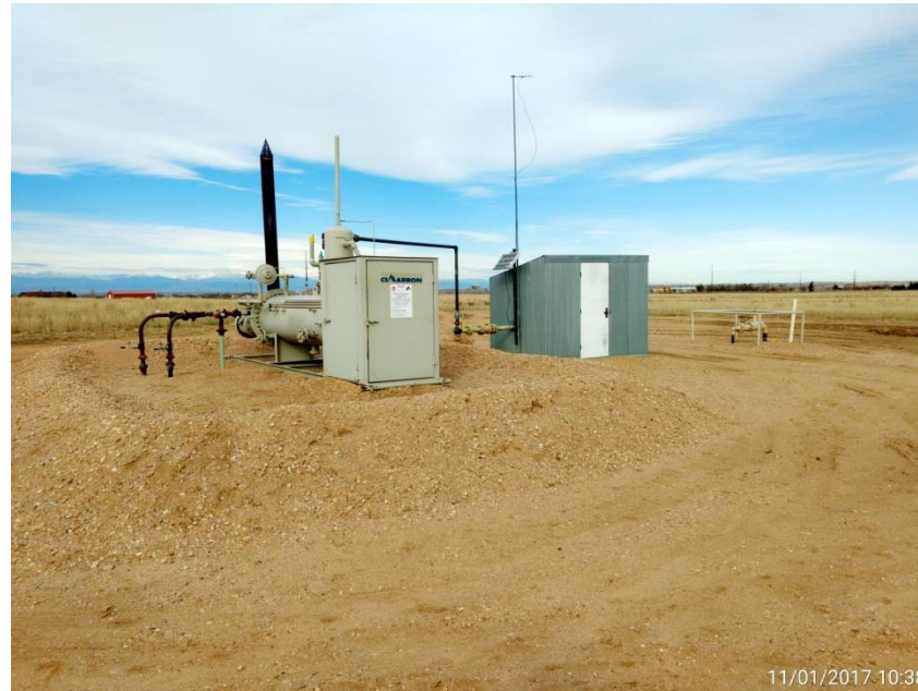
Separator & Meter Run
