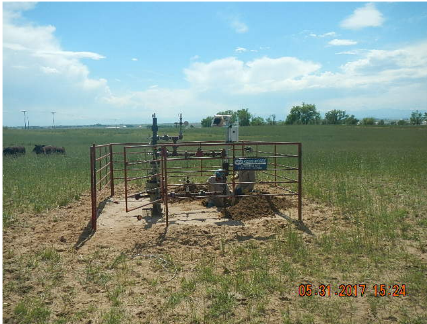
1" STEEL RISER ABANDONMENT PER NTO
