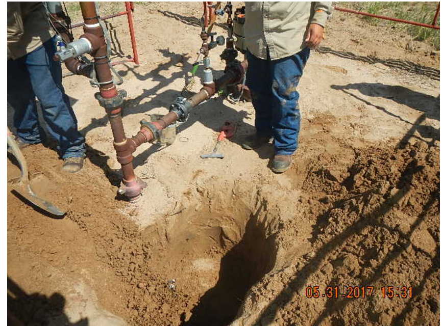
1" STEEL RISER ABANDONMENT PER NTO
