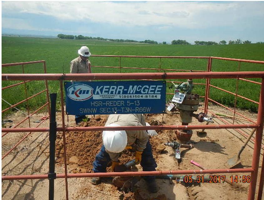
1" STEEL RISER ABANDONMENT PER NTO
