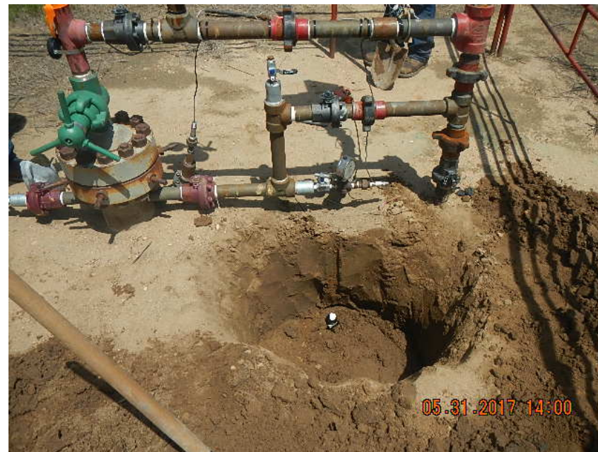
1" STEEL RISER ABANDONMENT PER NTO
