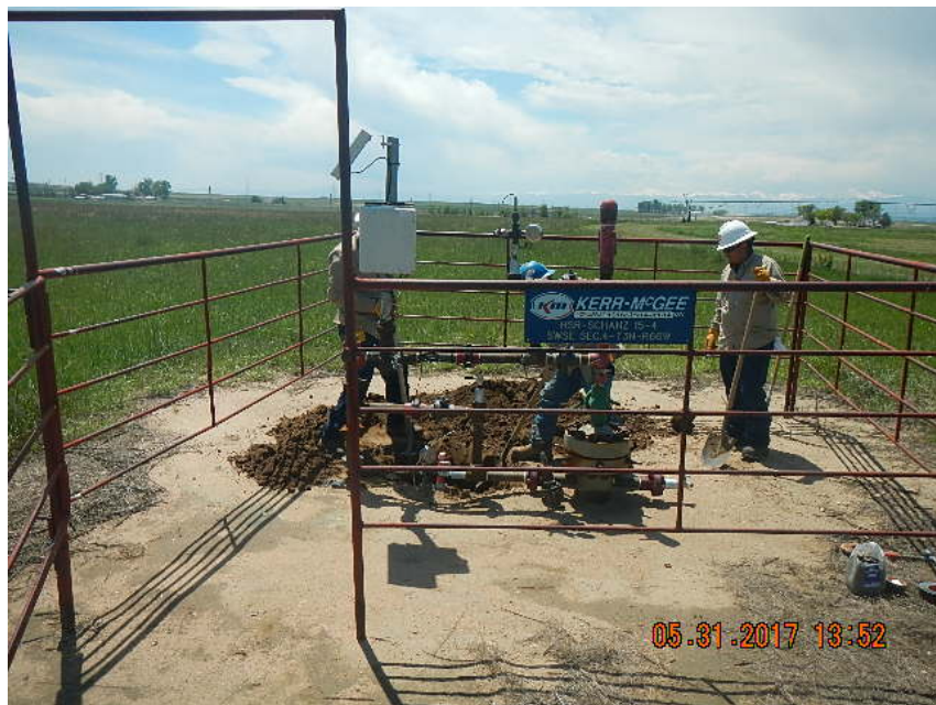
1" STEEL RISER ABANDONMENT PER NTO
