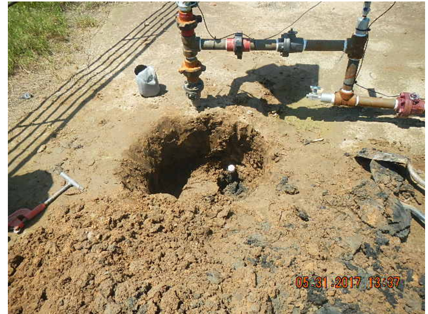
1" STEEL RISER ABANDONMENT PER NTO
