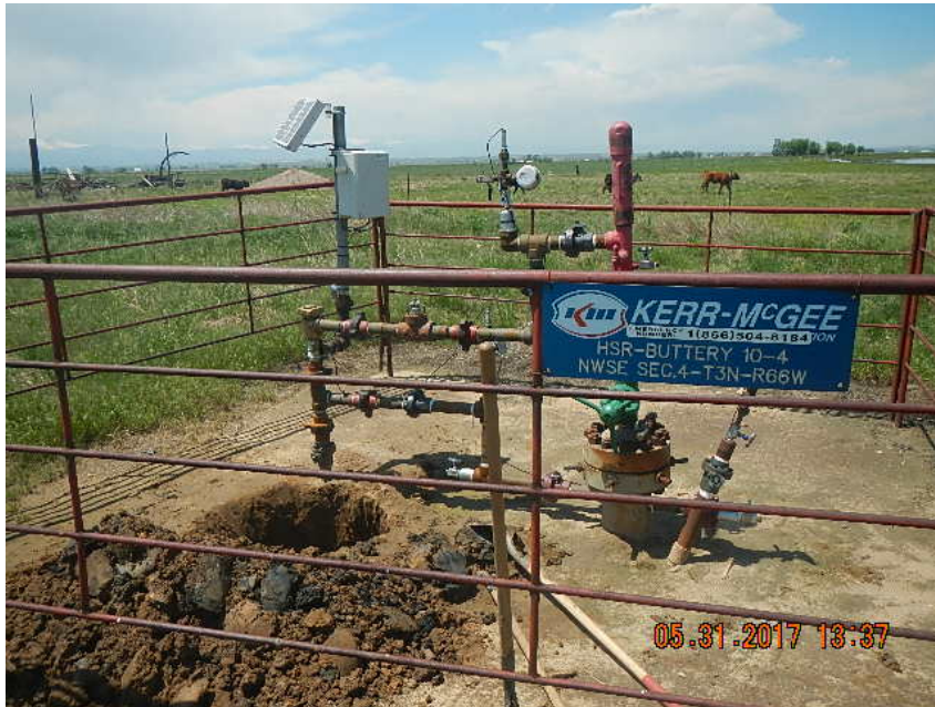
1" STEEL RISER ABANDONMENT PER NTO
