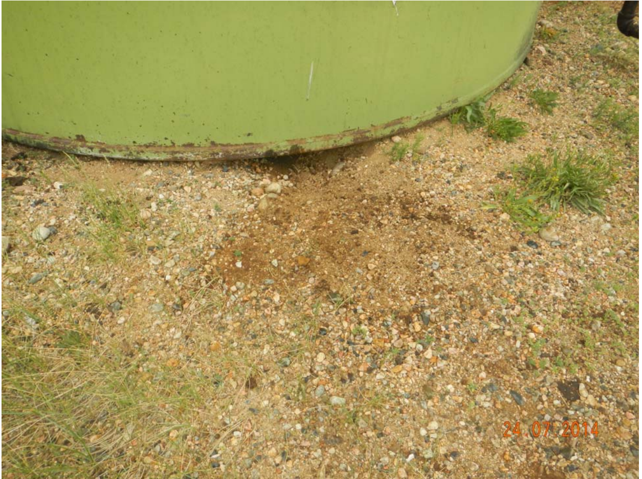
8.) Visual staining beneath tank.
